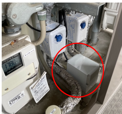
図 3：ゲートウェイユニット設置の様子
